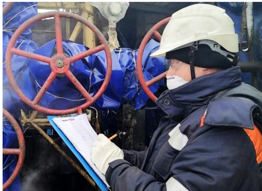
Снятие показаний устьевых давлений на фонтанной арматуре
