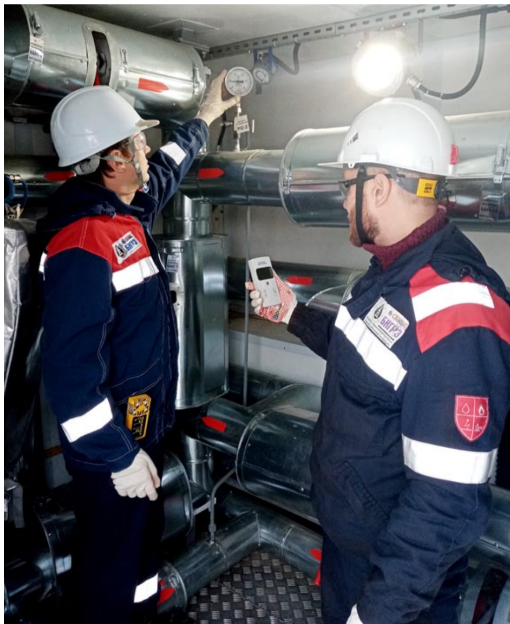
Работа с приборами учета на многофазном замерном комплексе
